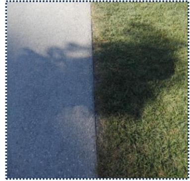
Fig. 5 – Lama di separazione tra differenti tipi di pavimentazioni
