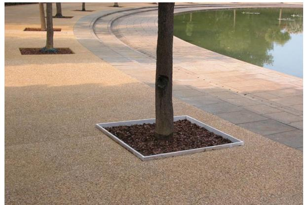
Fig. 13–Particolare dell'aiuola su pavimentazione in conglomerato cementizio drenante
