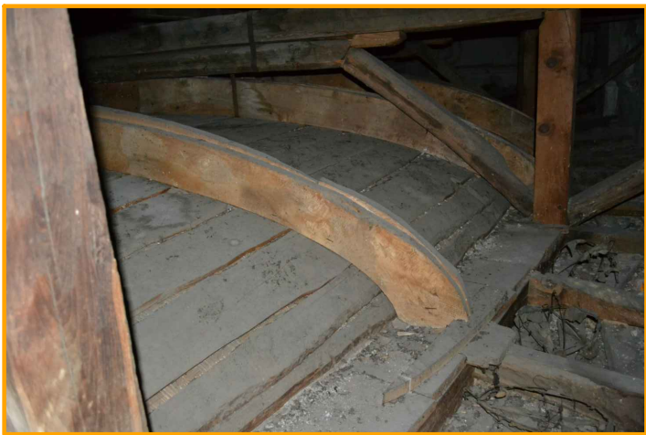
Struttura lignea di chiusura della platea del teatro a cui è appeso il plafond in canniccio intonacato e dipinto
